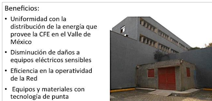
Figura 5. Subestación eléctrica derivadora
